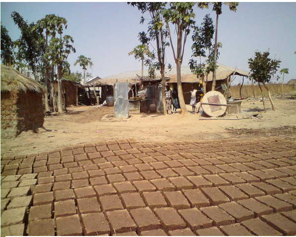
Der bygges på bibelskolen, men forinden skal mursten støbes og tørres.
